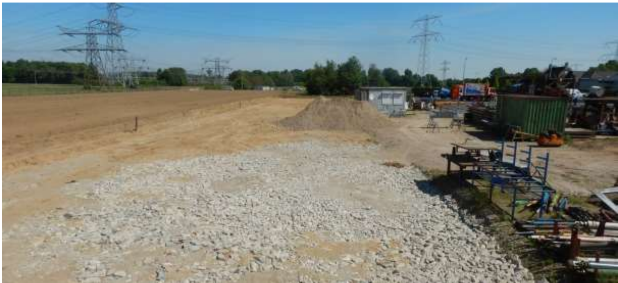
Figuur 15: Het reeds tot circa 60 cm –mv ontgraven centrale deel van het plangebied (gezien vanaf de zuidgrens in noordelijke richting). Het zuidelijke deel van de ontgraving is aangevuld/verhard met gebroken betonpuin.
